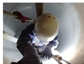
槽内出入風景
